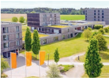
Fügt sich organisch in das bestehende Klinik-Ensemble ein: der neue Wohnturm (hinten) der Fachklinik Höchst für suchtkranke Frauen.
